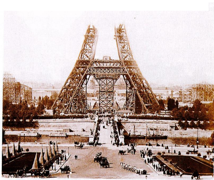
Doc. 18 : La Tour Eiffel en construction (achevée en 1889)
